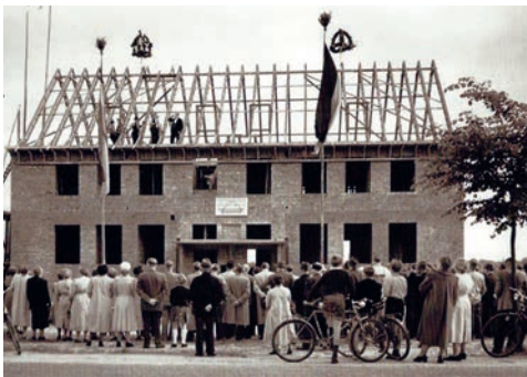
Bei der Feier zu Grundsteinlegung und Richtfest wehten am 24.8.1954 vor dem Rohbau des neuen Verwaltungsgebäudes zwei schwarzrotgoldene Fahnen; zahlreiche Einwohner folgten den Ausführungen von Gemeindedirektor Otto Tönsgöke, Landrat Franz Specht und Oberkreisdirektor Helmut Schütz.
