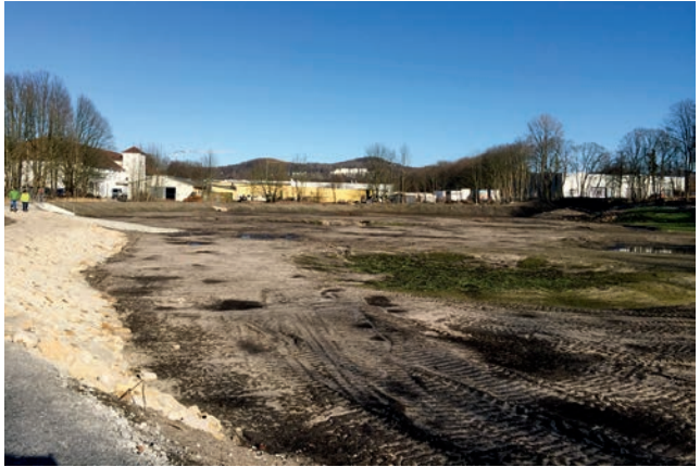
Hochwasserschutz im Luttertal
