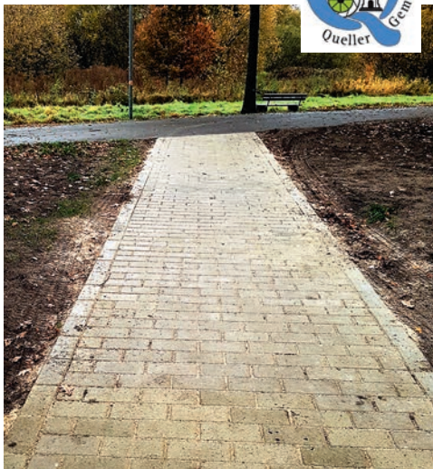
Der neu gepflasterte Zugang vom Parkplatz zur Finnbahn
