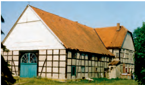
Das Fachwerkhaus vor dem Umbau (Repro: Queller Archiv).
