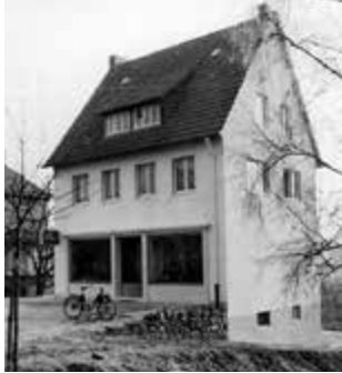
Neubau 1954 an der Carl-Severing-Straße 97
