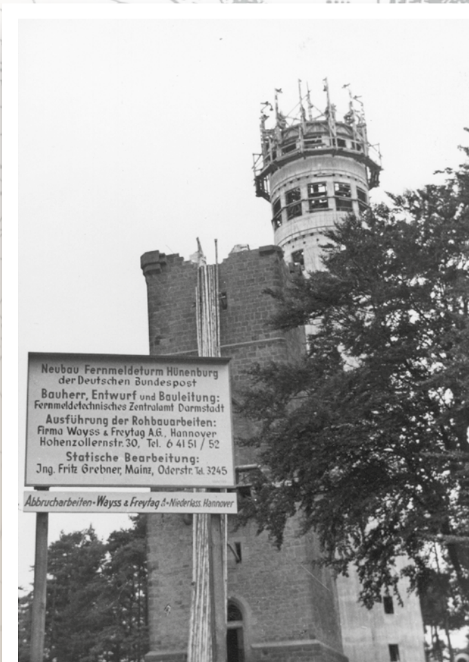
1952 wurde der Drei-Kaiser-Turm abgebrochen und in nur 80 Tagen Bauzeit ein Fernsehturm aus Beton errichtet. (Foto: Queller Archiv)
