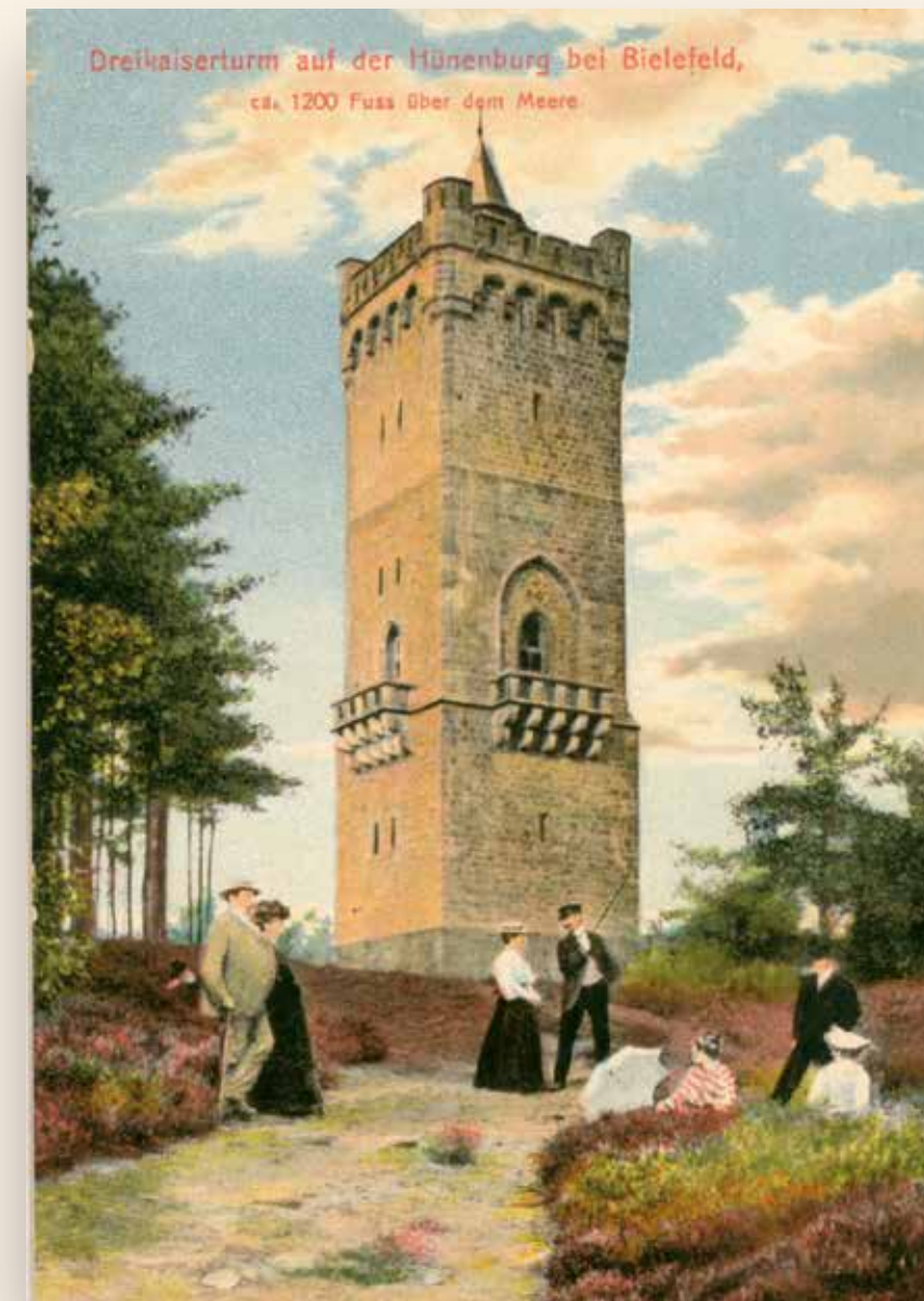
1894 wurde der Drei-Kaiser-Turm eingeweiht. Das quadratische Sandstein-Bauwerk hatte eine Gesamthöhe von 32,7 m; 128 Stufen führten zur ca. 25 m hohen Plattform. (Ansichtskarte um 1900: Queller Archiv)
