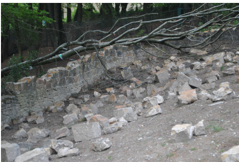
2020 wurde die Terrassenmauer teilweise abgetragen.
