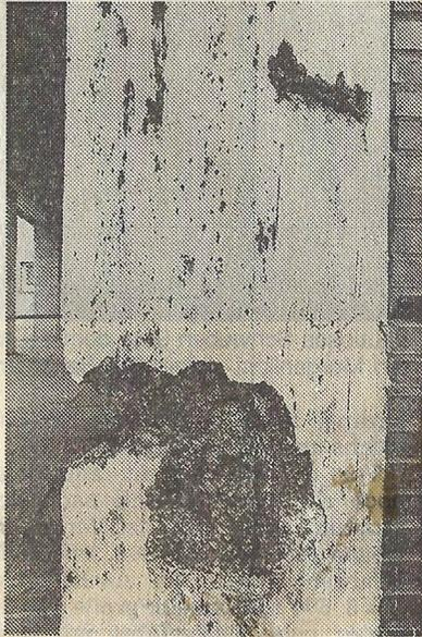
An einigen Stellen weisen die Betonpfeiler starke Risse auf, ist der Beton schon stark abgebröckelt.
